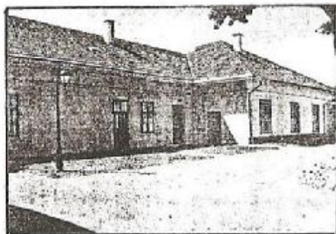
Bývalá budova pošty v areáli zámku v Bytči
